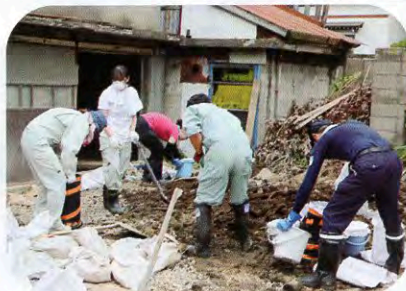
▲泥出し・荷物出し等の作業
